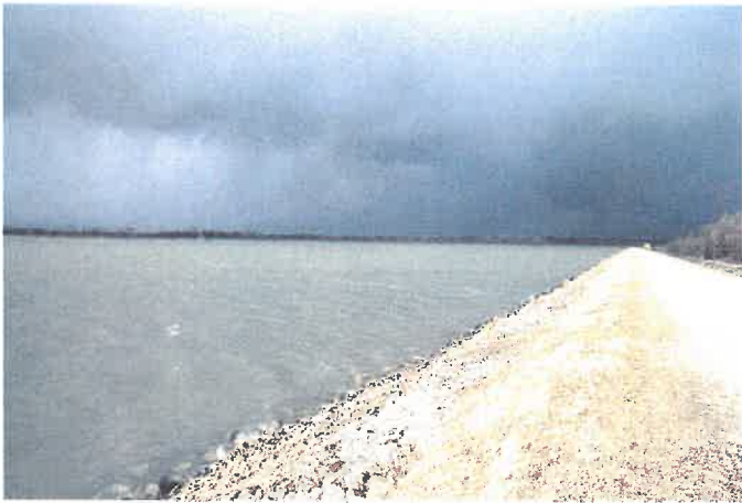
Abb. 3: Rhein bei Altenheim - kanalisierter Flußabschnitt
