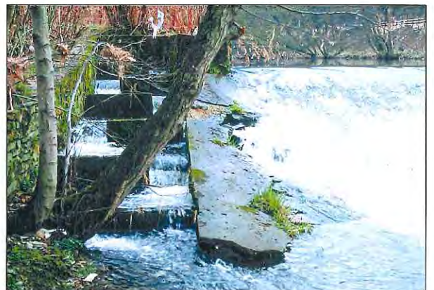
Absturz mit Fischtreppe
