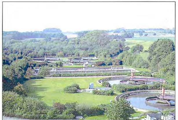
gewässerunverträgliche Anlage: Kläranlage
