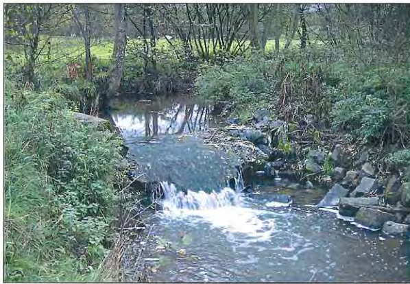
hoher Absturz (0,3 bis 1m)
