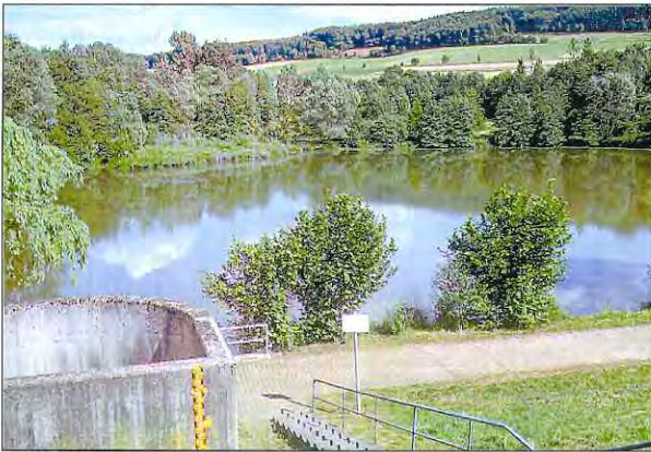
gewässerunverträgliche Anlage: Hochwasserrückhaltebecken
