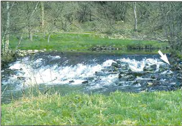
Absturz mit Teilrampe
