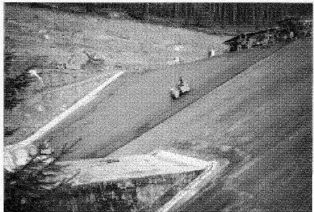
Einbau der Außenhautdichtung mit Asphalt
